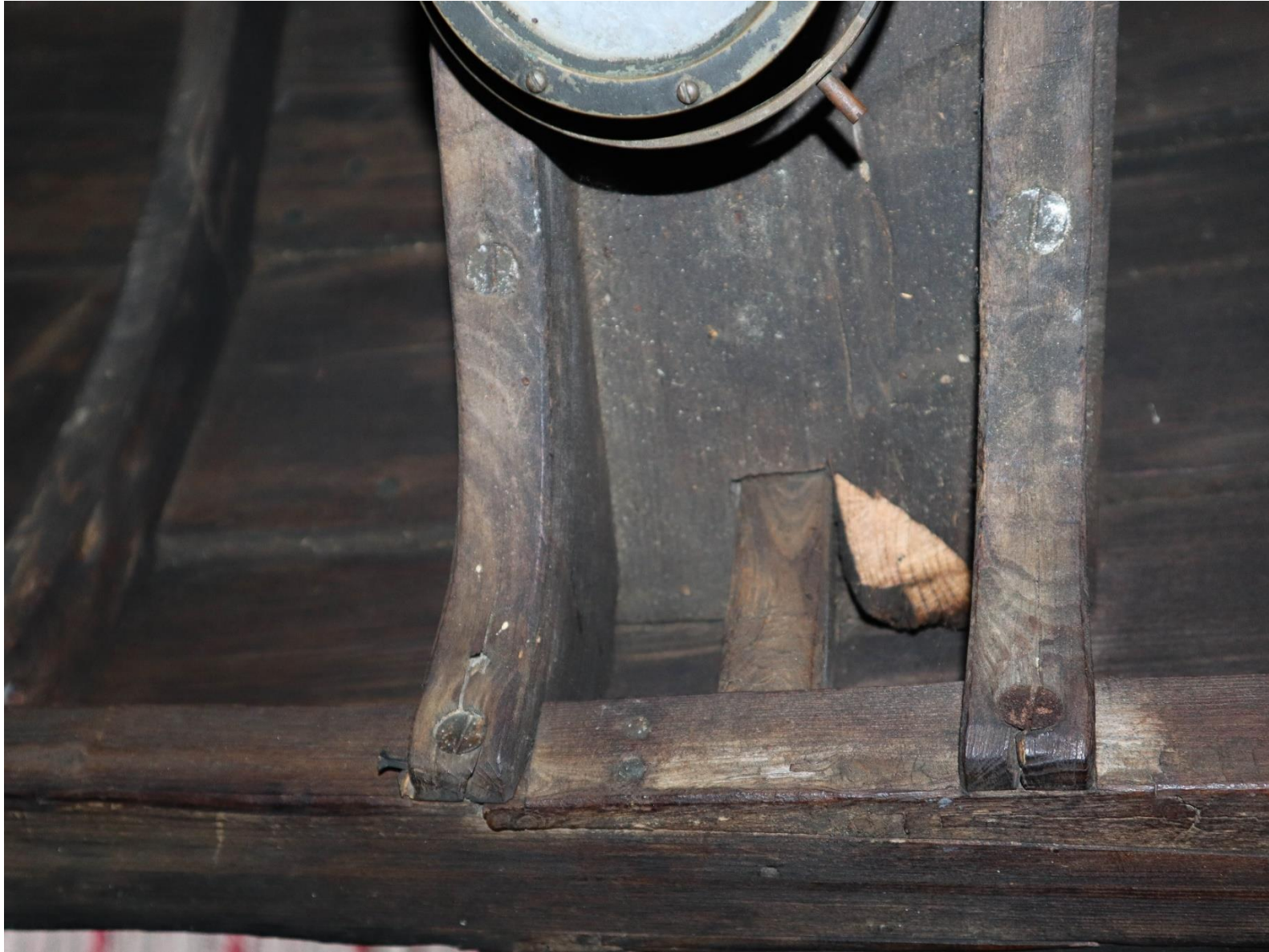
Mastopenkin kiinnitys polvioilla veneen partaaseen ja laitaan
