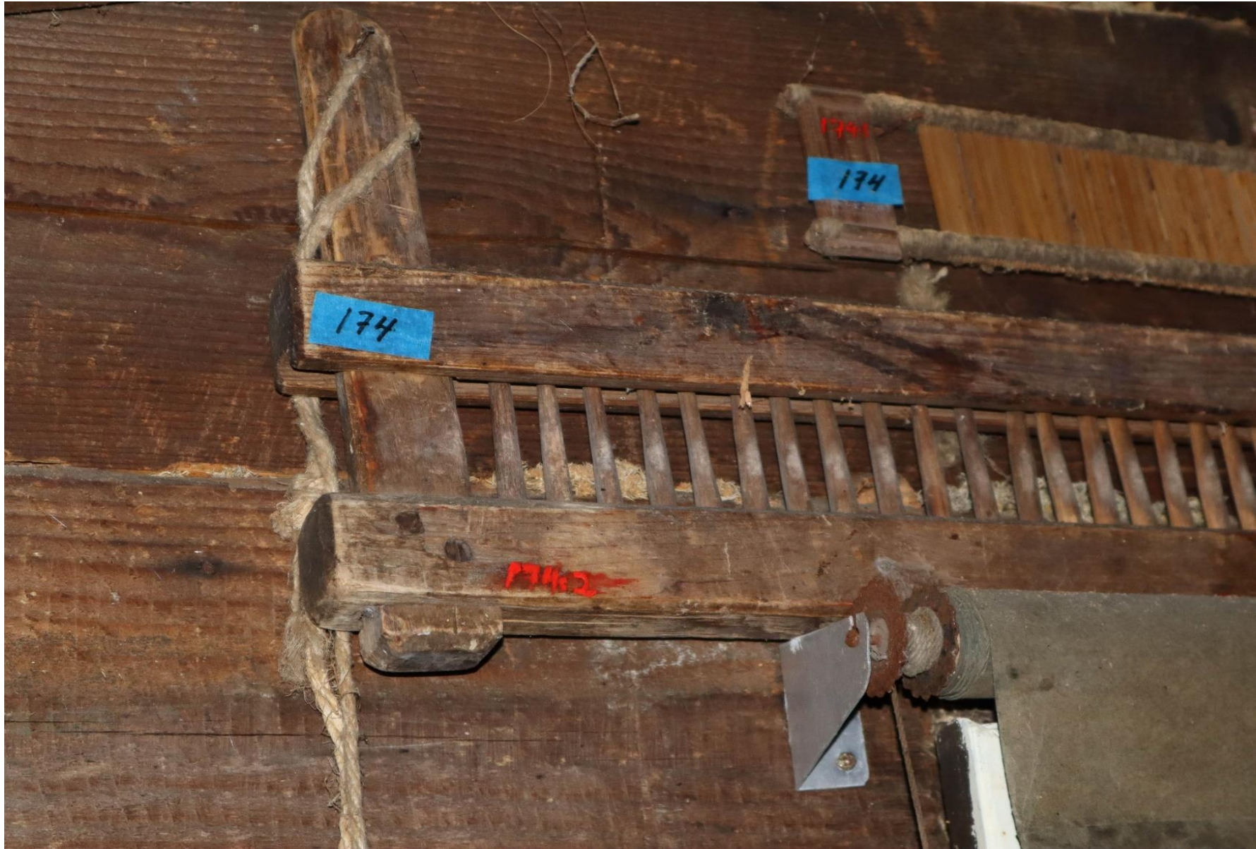
Ikkunan yläpuolella pirta eli kaide ja kierre- eli tukkipirta ja pimennysverhon lukitsinkulma.
