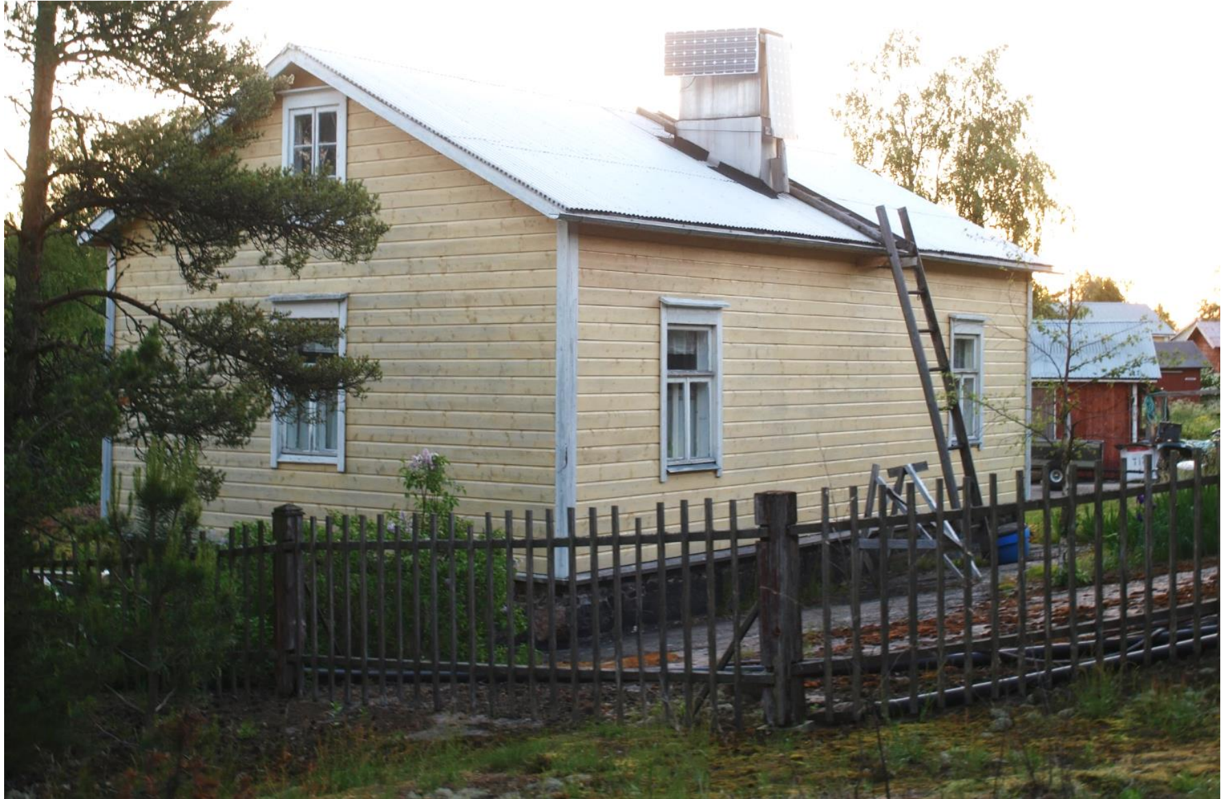
Topin Villen talo Niileksenkujan itäpuolella
