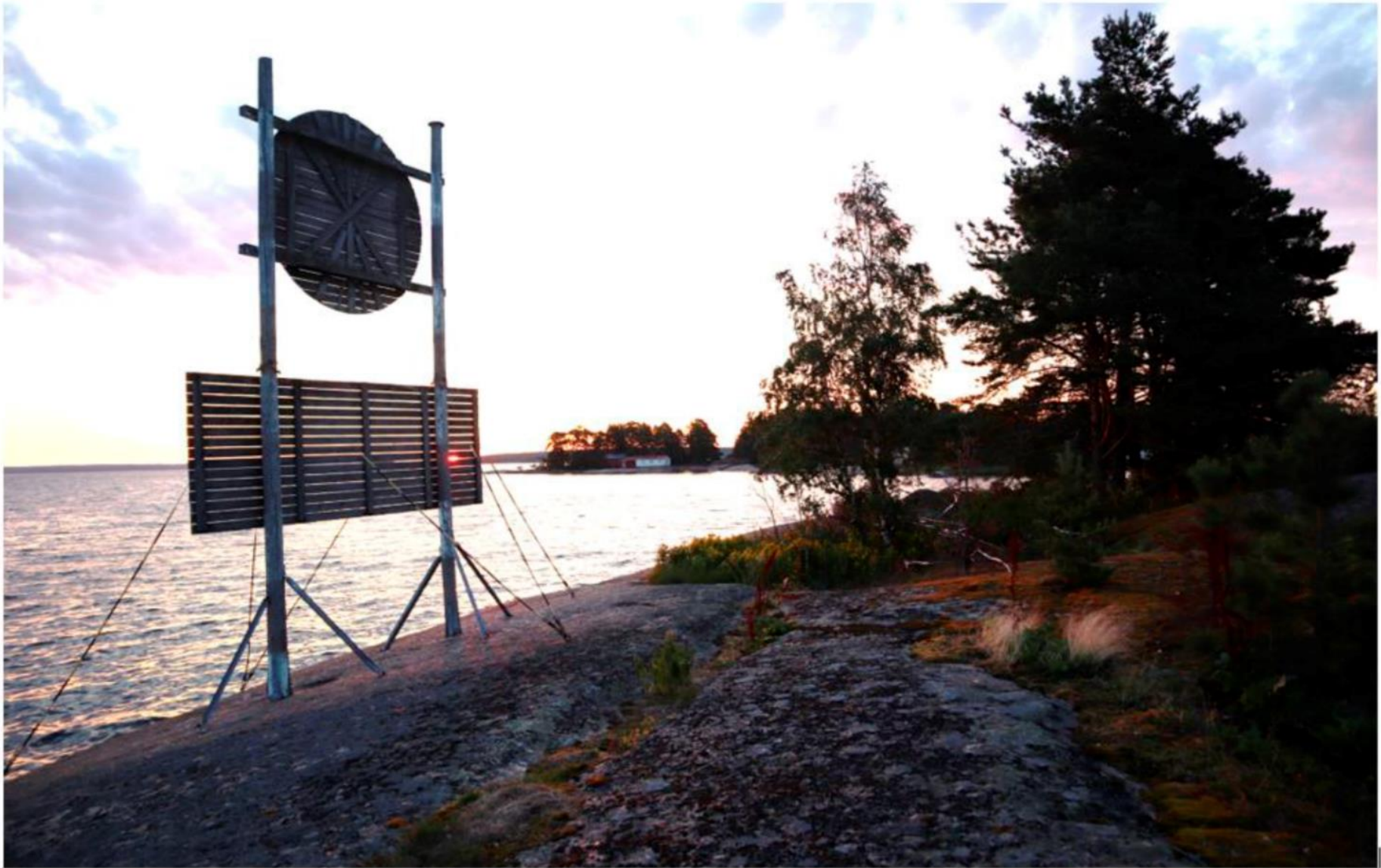
Kaapelin etummainen linjataulu Jyrkäskalliolla auringon noustessa. Taustalla Ketholma.
